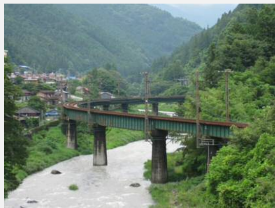
図2-10-49 渡らずの鉄橋
