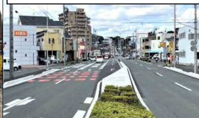
事故危険箇所における交差点改良 (右折レーンの設置)
