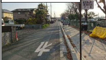
通学路における安全対策 (歩道の設置)
