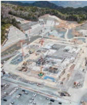
新清掃工場建設現場（4年3月25日撮影）
