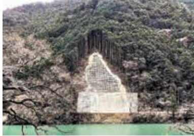
道路斜面の防災対策箇所
