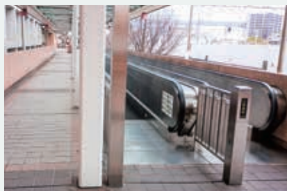
アクトシティ浜松に設置されている動く歩道
