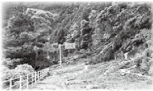
令和5年台風第2号に伴う6月豪雨による被害 国道152号(秋葉トンネル北)
