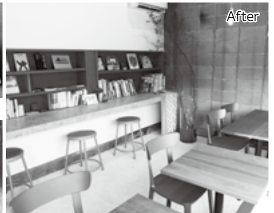
▲カウンターや床には、瓦の廃材を混ぜた材料を使用しました
