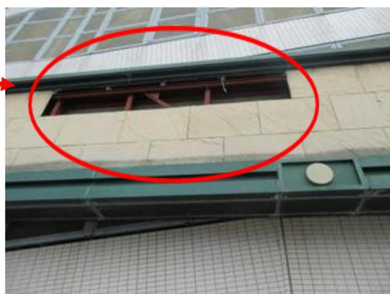
(3) 状況 外壁ボード3枚(1枚 600mm×900mm)が剥落。人的・物的被害なし
