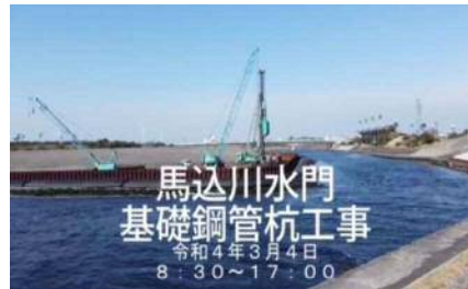
「基礎の鋼管杭の打ち込み工程を紹介！」
