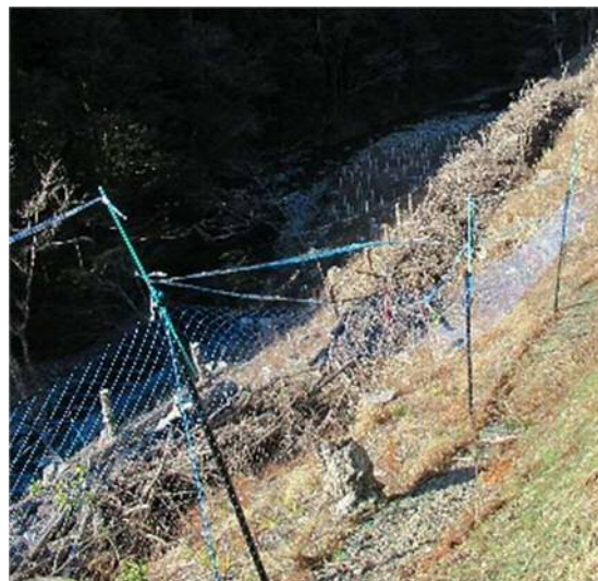
龍山町白倉 皆伐 撤収前に作業道に枝を集めて敷き詰め作業。雨水による洗堀を防止。
