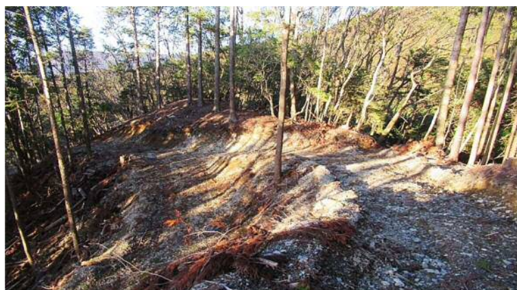
天竜区熊 杉林の間伐 作業道の開設状況 急斜面への開設。 スイッチバック。
