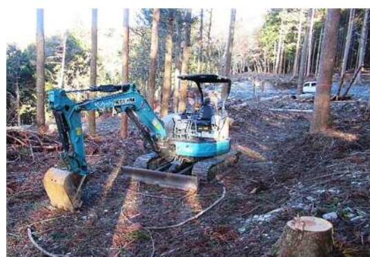
天竜区熊 杉林の間伐 作業道の開設状況 急斜面への開設。 スイッチバック。
