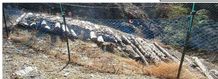
龍山町白倉 皆伐 終了後、作業道の入口付近に残材を並べて敷き詰め。雨水による洗堀を防止。
