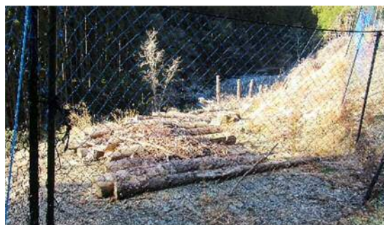
龍山町白倉 皆伐 終了後、作業道の入口付近に残材を並べて敷き詰め。雨水による洗堀を防止。
