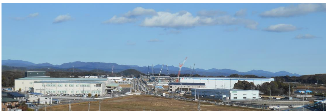
工場建設が進む都田地区 （第三都田地区工場用地）
