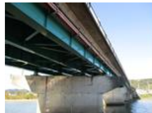
「落合橋の長寿命化工事」 （細江町気賀地内）
