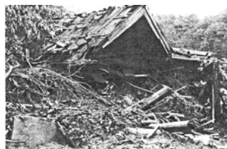
がけ崩れによる被害(S49年)
