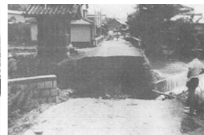
立谷川のはん濫による 道路流出(三ヶ日町平山)
