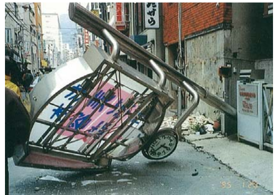
屋外物の落下による被害例
