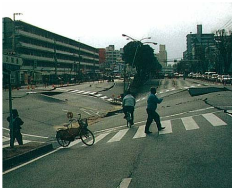
道路の沈下による被害例
