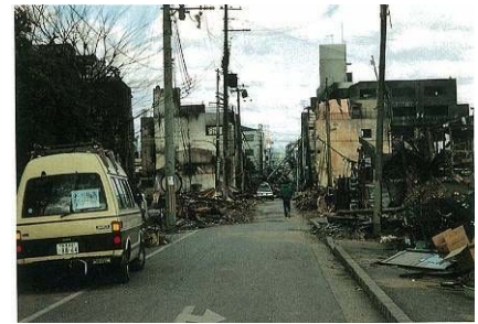
■ 建物やブロック塀の倒壊被害例
