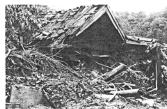
がけ崩れによる被害(S49年)
