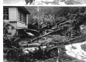
台風7号が引き起こした土石流による被害 (旧春野町若身,S44年)
