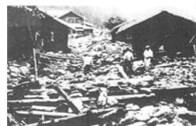
翁川のはん濫による土砂と流木による被害 (水窪地区梅島,S35年)
