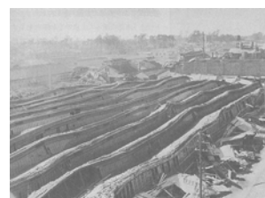
工場の倒壊(高塚町、1944 年)
