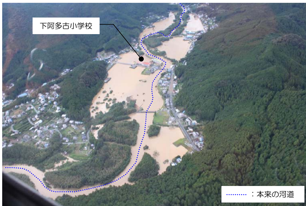
両島橋周辺の浸水状況（航空写真）
