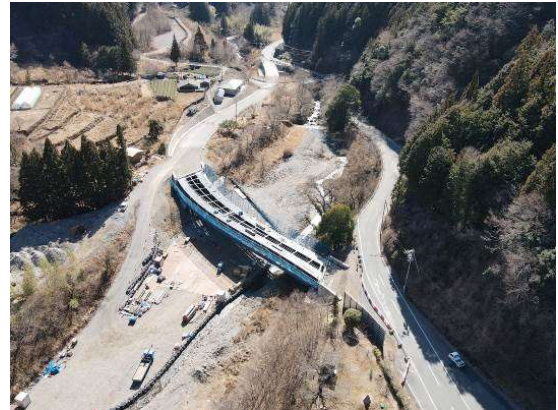
▲国道152号(池島～大原)(仮称)10号橋付近
