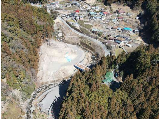
▲国道152号(池島～大原)(仮称)1号橋付近
