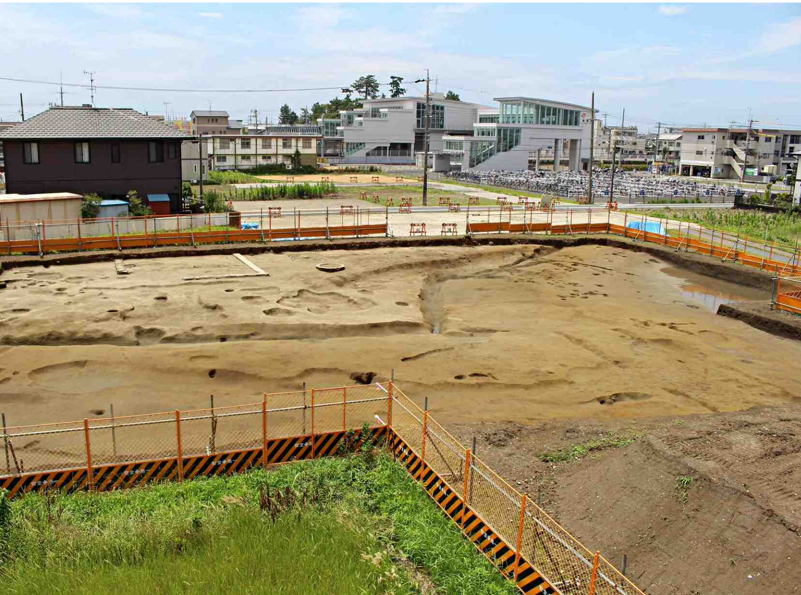
B区全景（北から）
