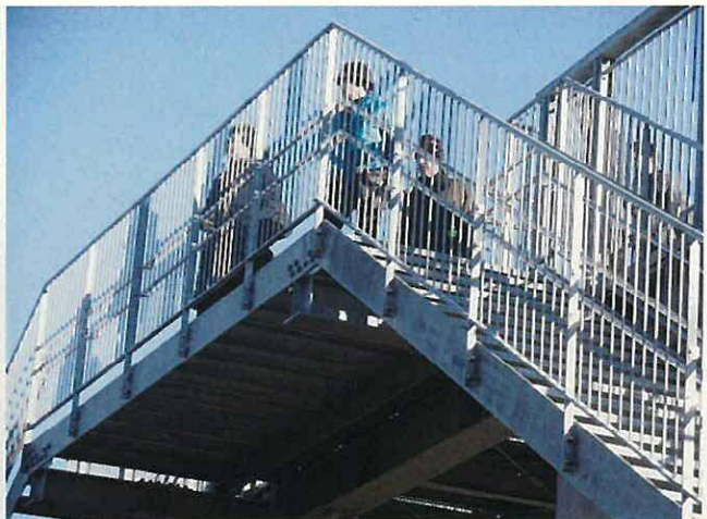
津波避難タワー 下方から撮影。
