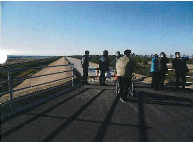
防潮堤五島工区にて(西方向)。
