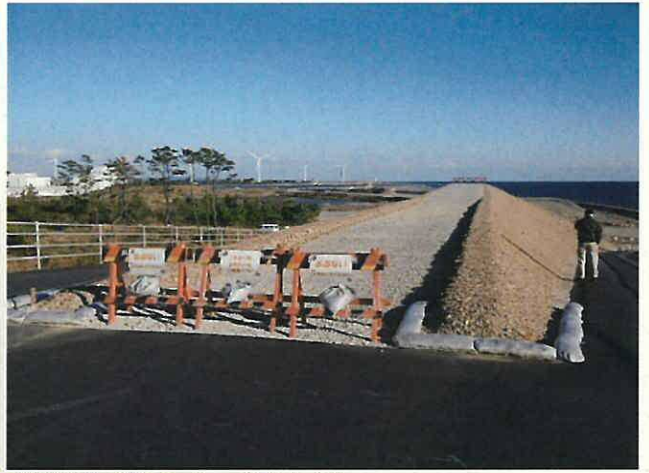
防潮堤五島工区にて(東方向)。
