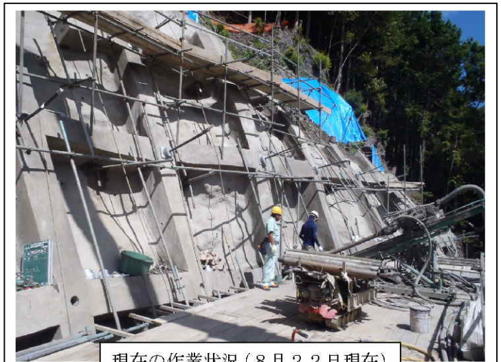
現在の作業状況（8月22日現在）
