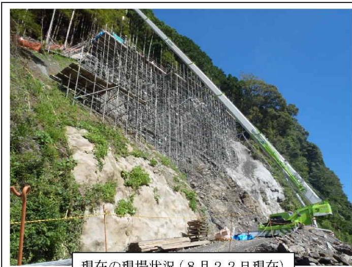
現在の現場状況（8月22日現在）
