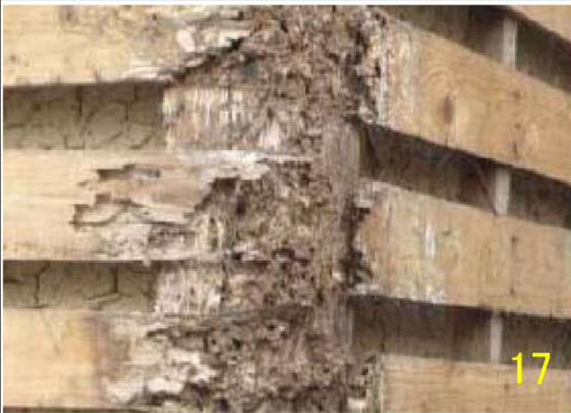
L 2 柱の著しい腐朽 (多数の場合 L 3)
