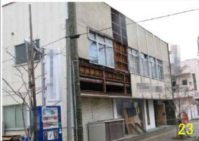
L 2 外壁ボードの部分的なはがれ
