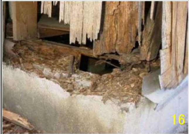
L 2 柱の抜け出し (多数の場合 L 3)
