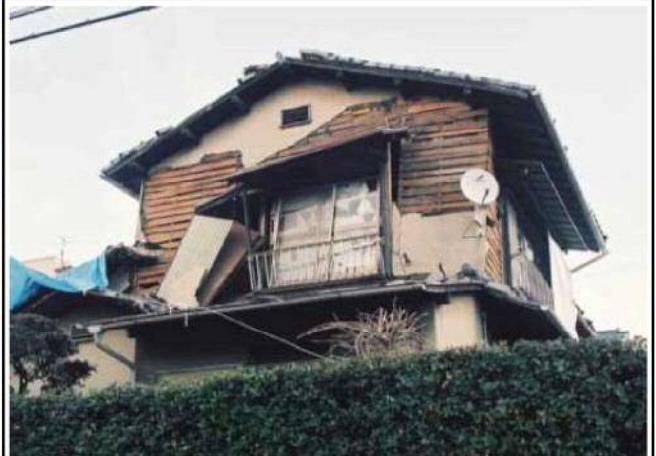
L 3 外壁モルタルの広範囲にわたる剥離
