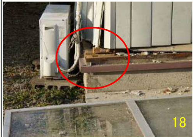
L 2 柱の抜け出し (多数の場合 L 3)
