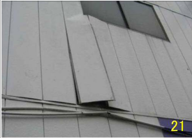
L 2 外壁ボードの部分的なはがれ
