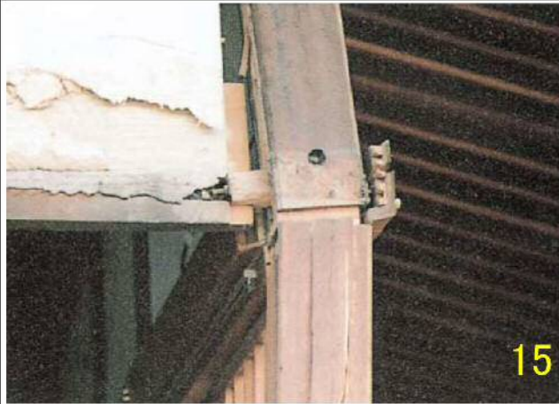
L 2 柱の著しい腐朽 (多数の場合 L 3)
