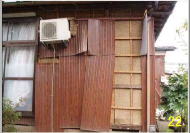
L 3 外壁モルタルの広範囲にわたる剥離
