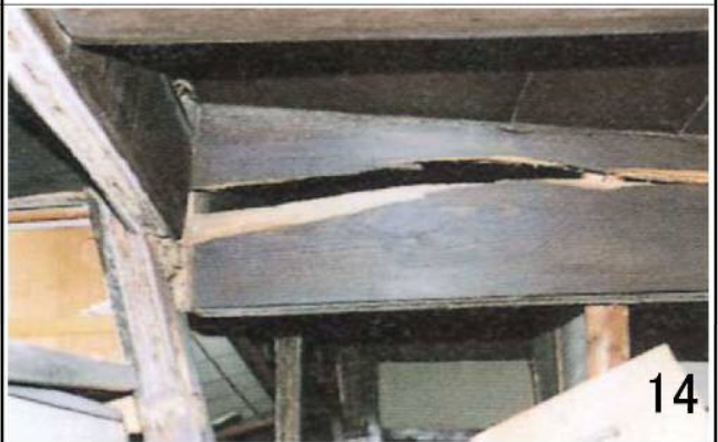
L2 柱、はりの割り裂け（多数の場合L3）
