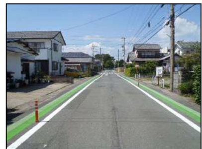
通学路におけるグリーンベルト設置
