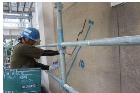
小規模改修工事(外壁改修)
