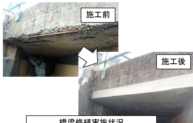
橋梁修繕実施状況 (市道和合 121 号線 1 号橋)
