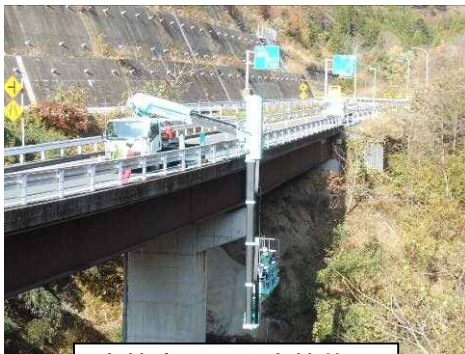
点検車による点検状況
