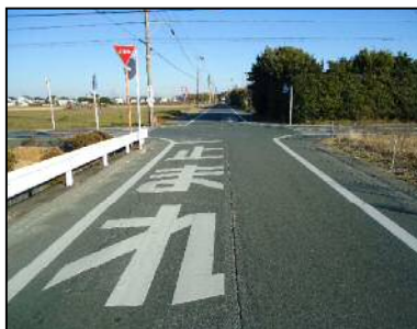
道路法定外表示(止まれ)の設置
