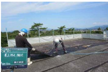
小規模改修工事(屋根改修)
