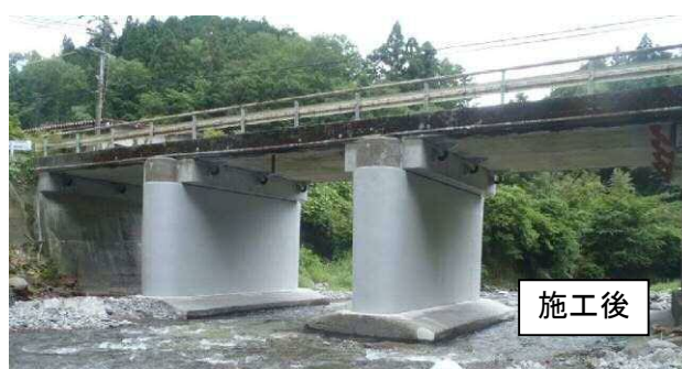
耐震補強実施状況 (国道 362 号川上橋)
