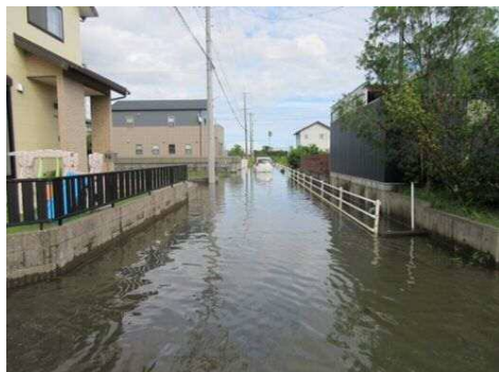
市内の浸水状況
