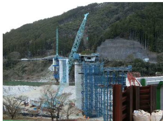
上部工架設状況（平成 31 年 1 月 11 日撮影）
