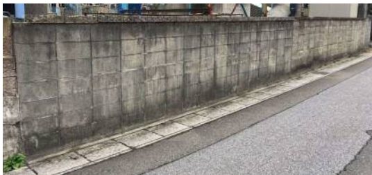
ブロック塀撤去前
