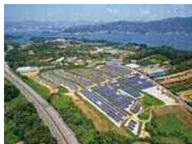
【大規模太陽光発電所】
