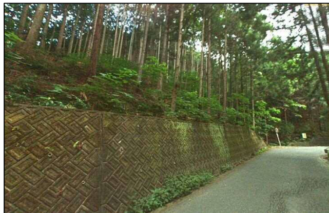
植生繁茂状況・法面状況確認 (360度画像)
