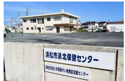
浜北保健センター(平口)
